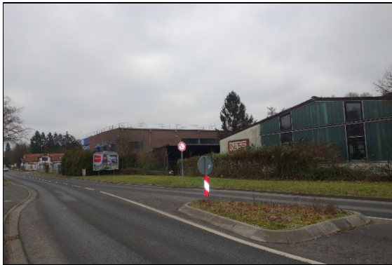
Blickrichtung nach Osten auf das Betriebsgelände Hauptstraße 226 – 230
